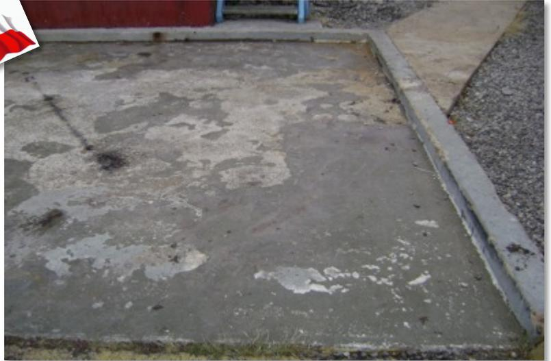
Se aprecia el avanzado estado de deterioro del recubrimiento original. Se procedió a escarificar toda el área, retirando la contaminación y otorgando una superficie limpia y rugosa. Se aplica **ENECRETE DuraFill** para emparejar la superficie previo a la aplicación de **CHEMCLAD XC** como escudo contra ataque químico severo.
